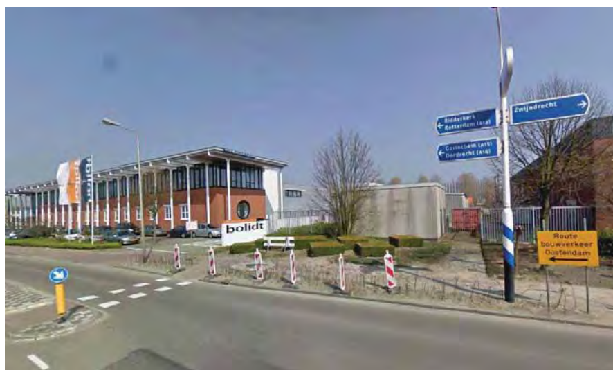
Figuur 2.2 Impressie projectgebied ter hoogte van de kruising Antoniuslaan-Nijverheidsweg (bron: google streetview)
