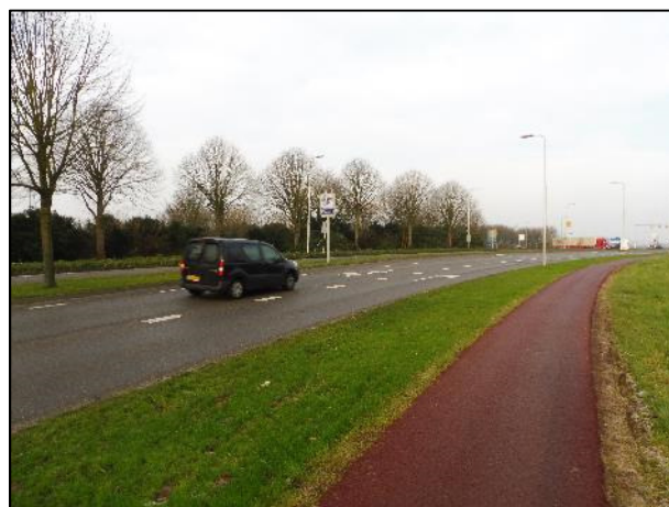
Foto 6: Noordeinde, fietspad en berm
