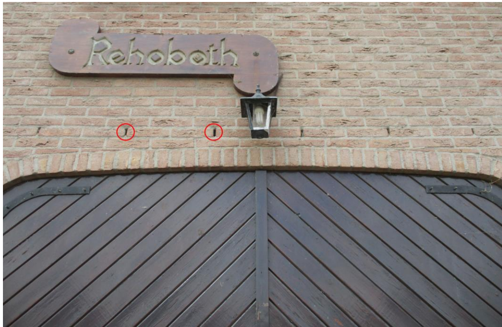
Figuur 4 Stootvoegen aan de oostzijde van de woning. Met rood omkaderd de stootvoegen welke mogelijk geschikt zijn als in- en uitvlieg opening, echter door de hoogte, de deur en de lamp zeer waarschijnlijk suboptimaal zijn.
