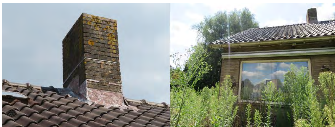
Figuur 5: Detailfoto's van schoorsteen en dak
