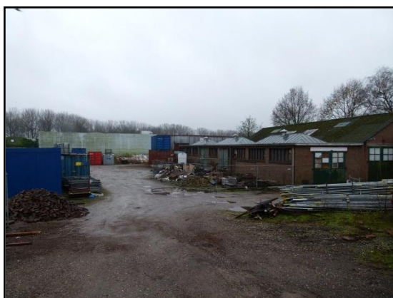
Foto A: Oostzijde van het plangebied. Verhard gedeelte met opgestapelde bouwmaterialen en rechts de grote schuur.
