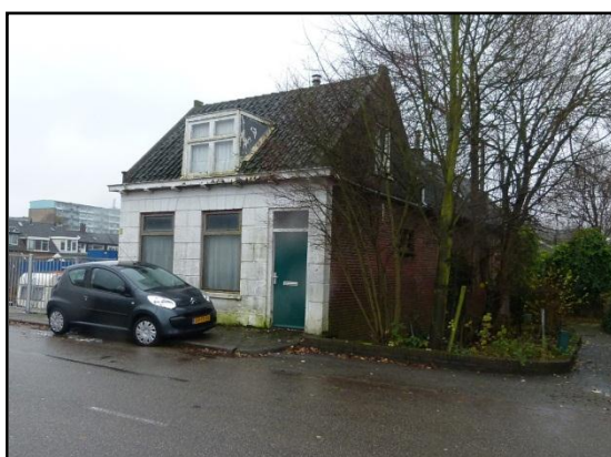
Foto C: Woonhuis in het noordwesten van het plangebied.
