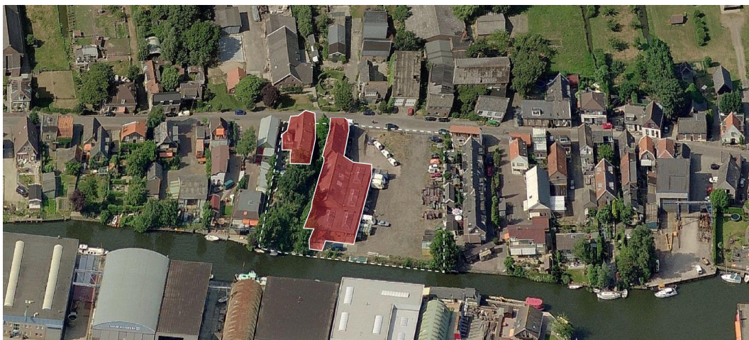
Afbeelding 3.7: bestaande situatie plangebied (in rood de te slopen bebouwing)
