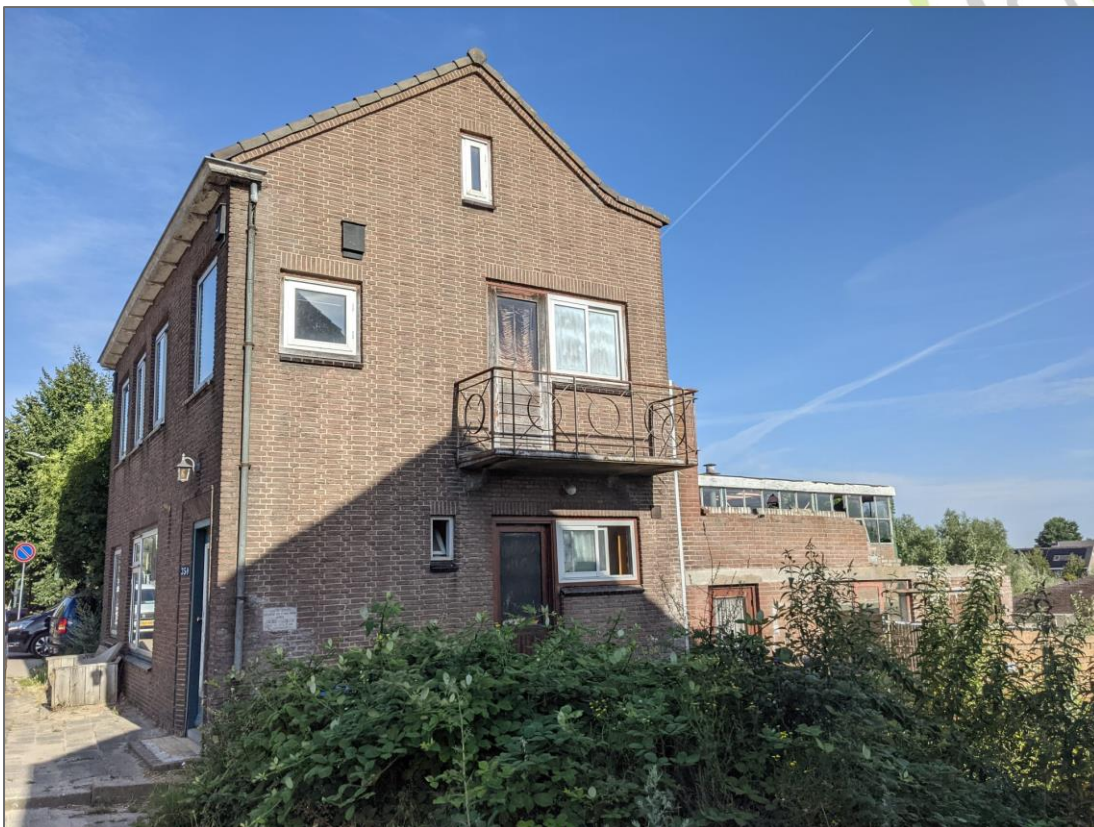
Oostelijke kopgevel woning 350. Foto: E.M.C. Schonck | Ecoresult B.V.
