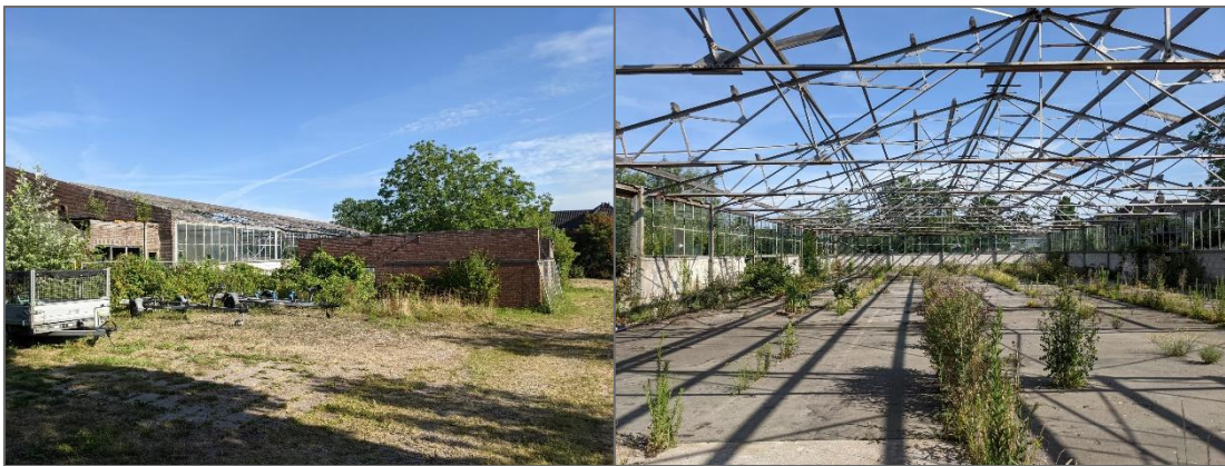
Figuur 6: Schuur 2. Links: buitenzijde schuur, rechts: binnenzijde schuur. Foto: E.M.C. Schonck | Ecoresult B.V.
