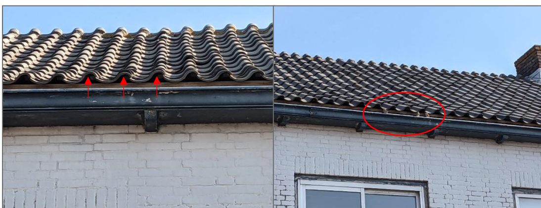
Figuur 13: Ruimte onder het pannendak van woning 348. De foto rechts geeft de locatie van het huismusnest weer aan de voorzijde van woning 348. Foto: E.M.C. Schonck | Ecoresult B.V.
