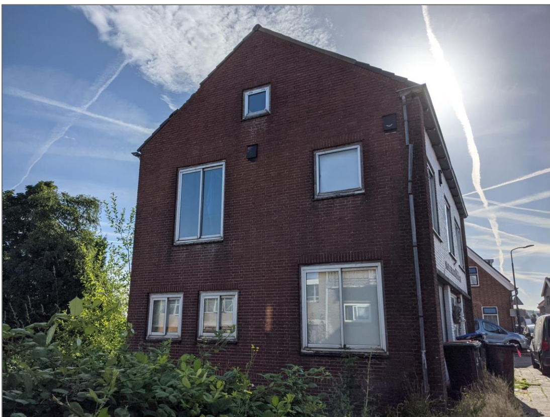
Westelijke kopgevel woning 348. Foto: E.M.C. Schonck | Ecoresult B.V.
