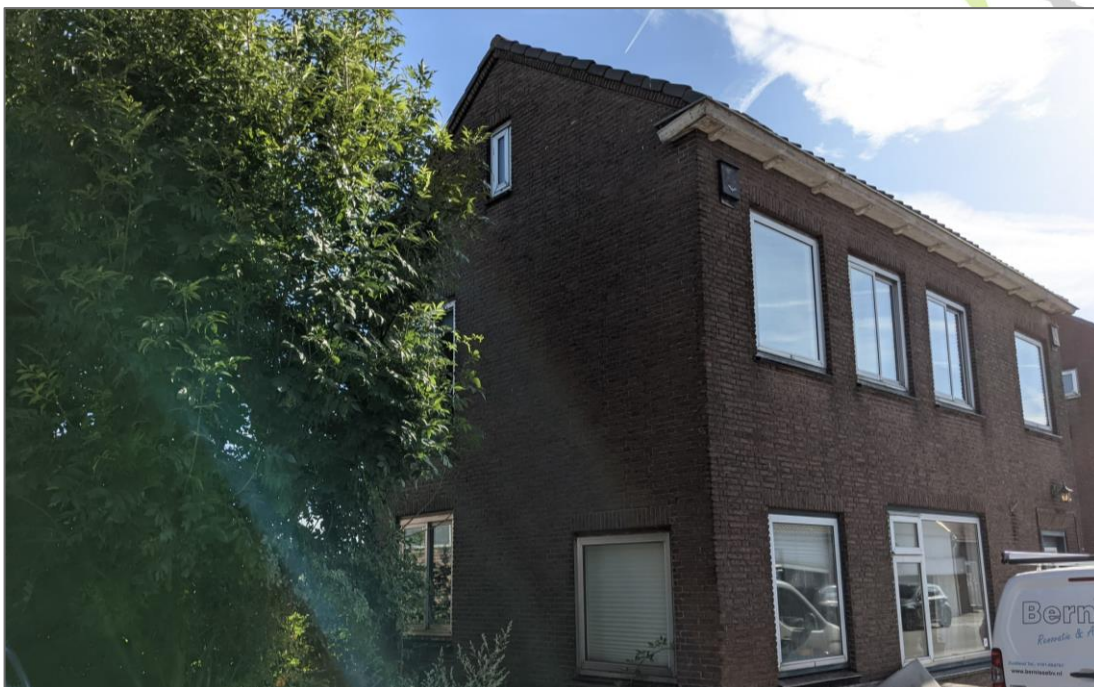
Westelijke kopgevel woning 350. Foto: E.M.C. Schonck | Ecoresult B.V.
