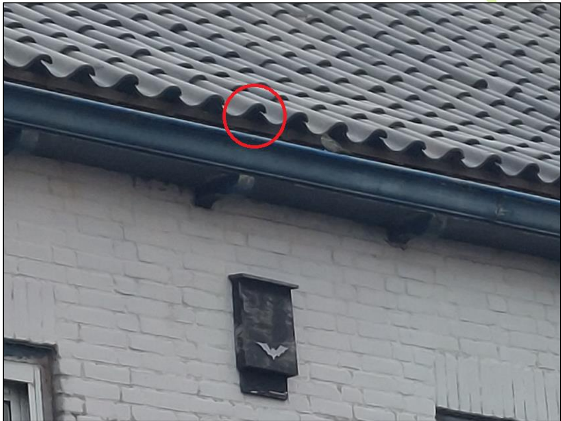
Figuur 5: Nestplaats huismus in het plangebied (rood omcirkeld) met mannetje huismus zichtbaar in de dakgoot. Foto: W. Mans-Naaijer | Ecoresult B.V.
