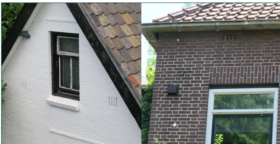
Figuur 3.1 In beide woning zijn er geschikte invliegopening en voldoende ruimte in de spouw voor gebouwbewonende vleermuizen.
