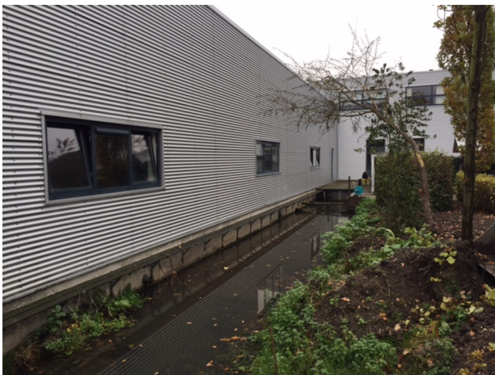
Figuur 2 In de huidige situatie bestaat de planlocaties uit een kantoorpand, een watergang en een houtopstand.
