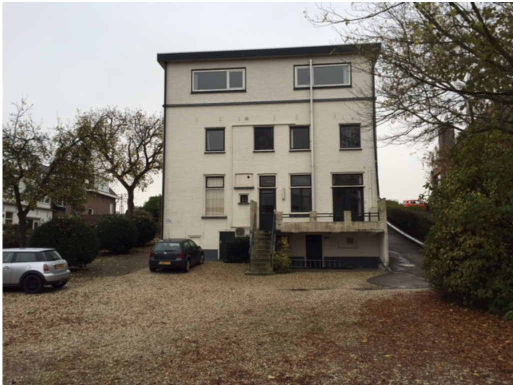
Figuur 3 Merwedestreek is voornemens het huidige kantoorpand te slopen ten behoeve van twee appartementen met kantoorruimte.
