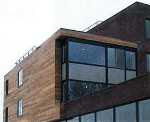
Kwetsbaar en weinig robuust: smalle stroken betimmerd met houten strips.
