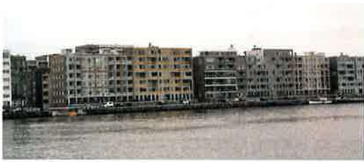
Aanzicht zuidzijde Java-eiland, Amsterdam De parcellering is hier vergelijkbaar met Papendrecht architect: o.m. Cruz en Ortiz
