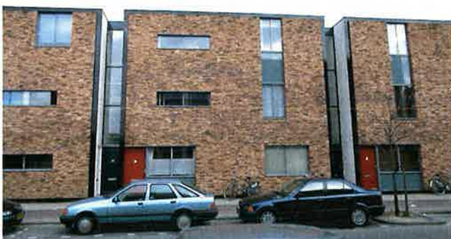
Voltstraat Tilburg, Rijnvos Voorwinde architecten.
