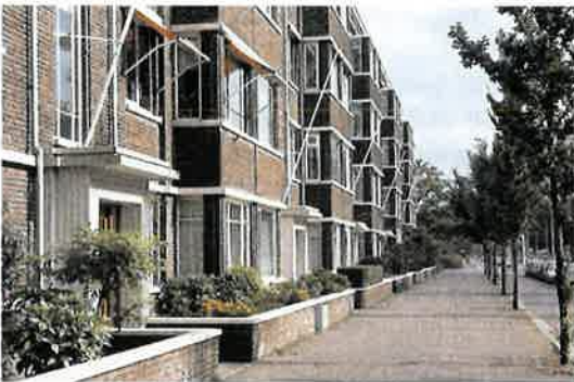
Robuuste, gemetselde voorzone, in relatie met een geprononceerde gevel met erkers en dakoverstekken Bohemen, Den Haag
