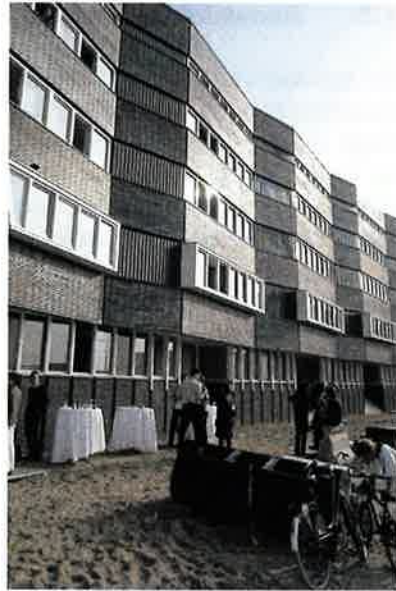
Kubische bouwmassa met verholen dak De Aker, Amsterdam Architect: Heren 5
