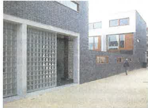
Hoge gemetselde tuinmuur, Kraaijhoek, Papendrecht Architect: DKV
