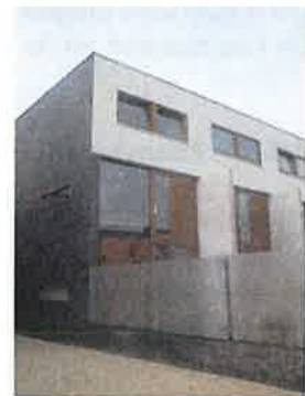
Muur met scherm Kraaijhoek, Papendrecht Architect: DKV
