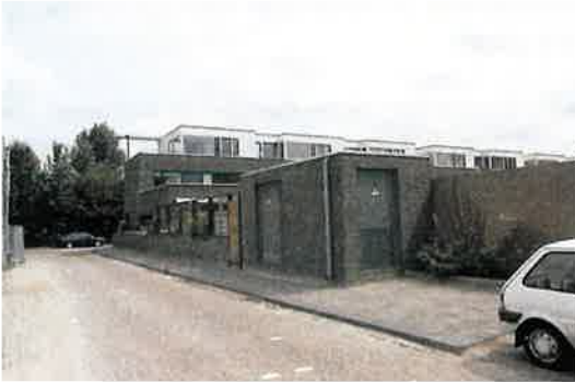
Inbouw transformatorhuis in tuinmuur Kanaaloevers, Apeldoorn Architect: Roelf Steenhuis, supervisor: Rein Geurtsen
