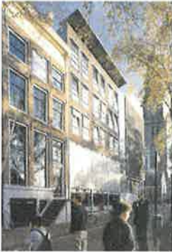
Gelaagde bouwmassa met dakoverstek Anne Frank huis, Amsterdam Architect: Benthem Crouwel
