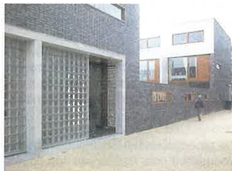
Hoge gemetselde tuinmuur, Kraaijhoek, Papendrecht Architect: DKV
