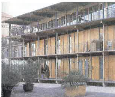
Troebele plastic; dubbele gevel met set-back op set-back KNSM-eiland, Amsterdam Architect: Jo Coenen
