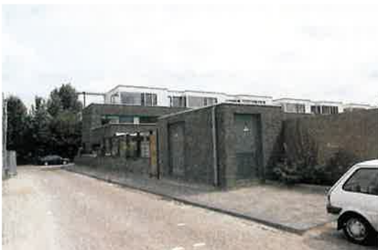
Inbouw transformatorhuis in tuinmuur Kanaalloevers, Apeldoorn Architect: Roelf Steenhuis, supervisor: Rein Geurtsen
