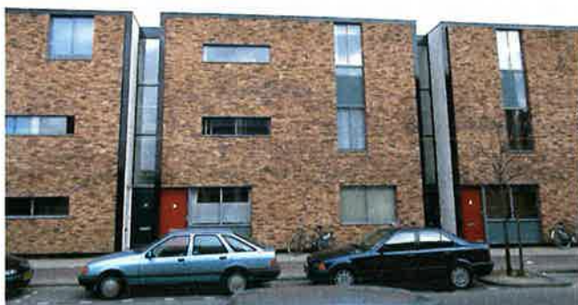
Voltstraat Tilburg, Rijnvos Voorwinde architecten.
