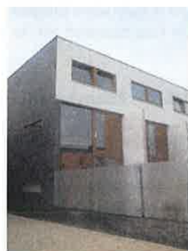
Muur met scherm Kraaijhoek, Papendrecht Architect: DKV
