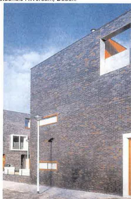
Woningbouw Veerweg, Papendrecht, DKV Architecten.
