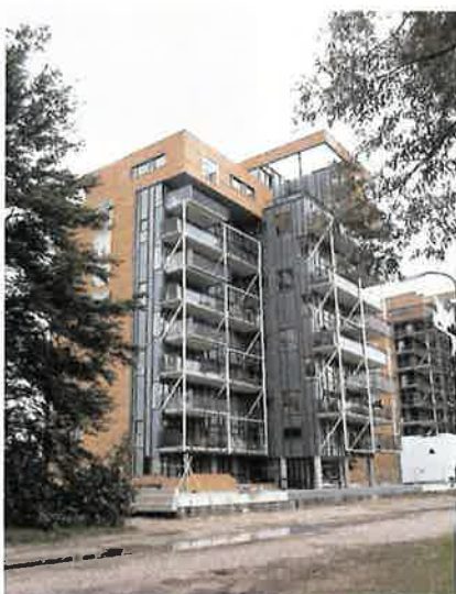
Woningbouw Kanaaloevers Apeldoorn Architect: Rudy Uytenhaak
