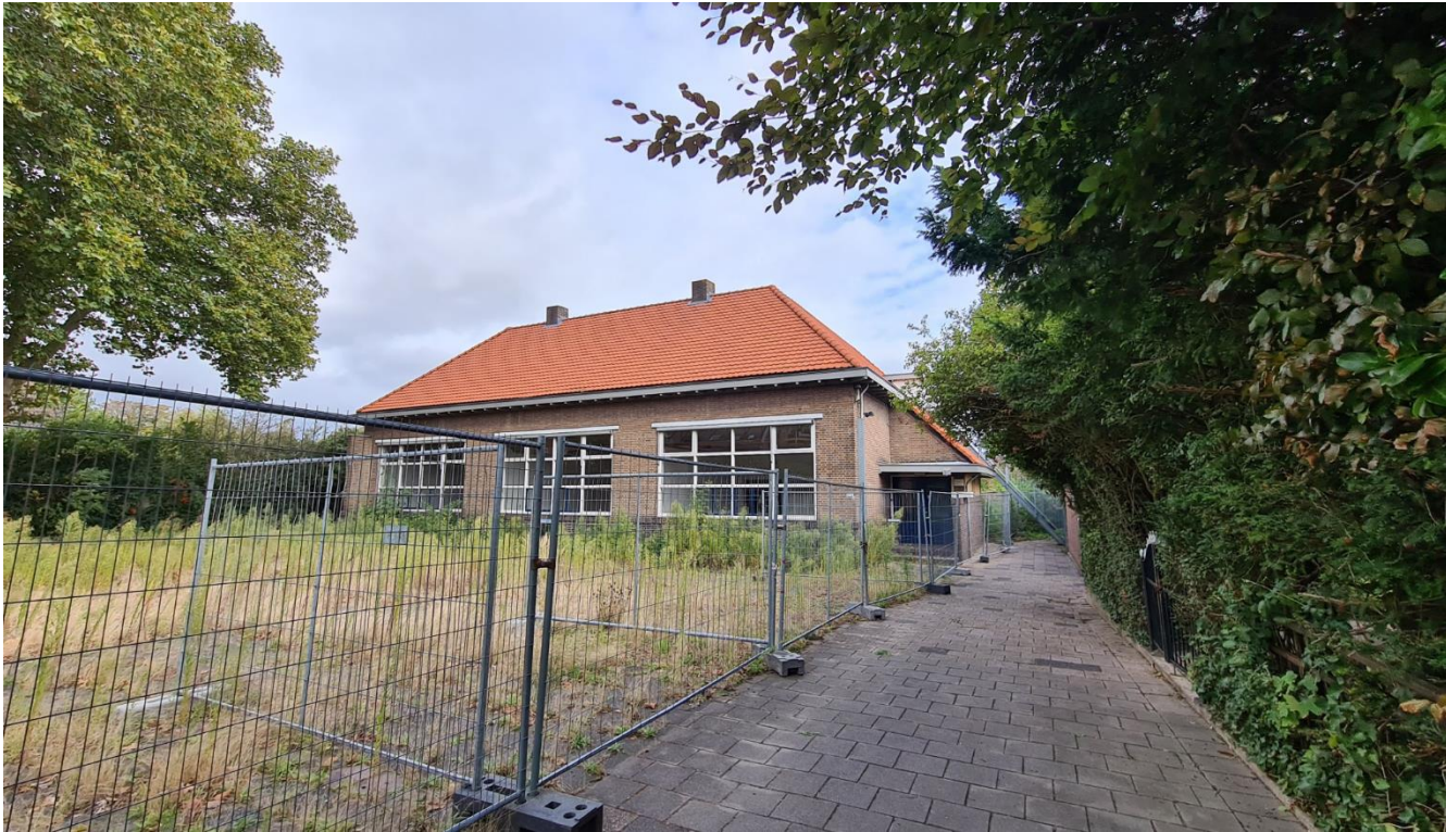
Figuur 4: Schoolgebouw en zuidelijke plein gezien vanaf het zuiden
