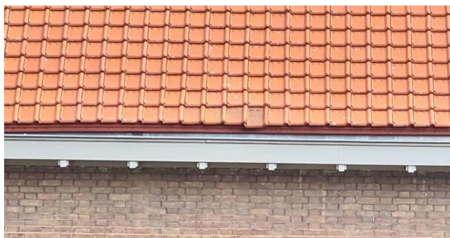
Figuur 12: Detail dak schoolgebouw
