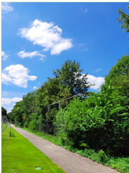
Onvoldoende bovengrondse groeiruimte door de aanwezigheid van de ballenvanger.
