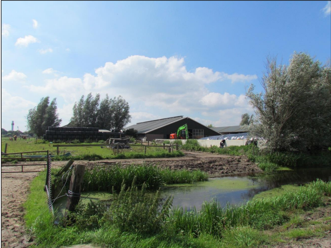
Afbeelding: de ligboxenstal met de er achter liggende voeropslag die grenst aan de kavelsloot. Dit is tevens het einde van de bouwblok. De strook achter en naast de ligboxenstal is de beoogde locatie voor de bouw van een nieuwe rundveestal en de uitbreiding van de voeropslag.
