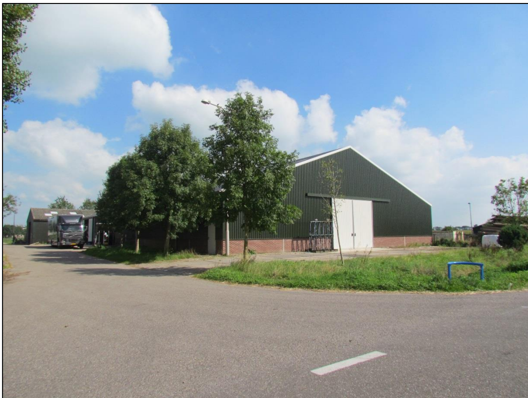
Afbeelding: de africhtingshal (van 20 x 40 meter) bij de insteekweg vanaf de Parallelweg. Dit is bij de voormalige rundveelocatie. De overige bedrijfsgebouwen in gebruik voor de paardenhouderij liggen van hieruit gezien links van de insteekweg.
