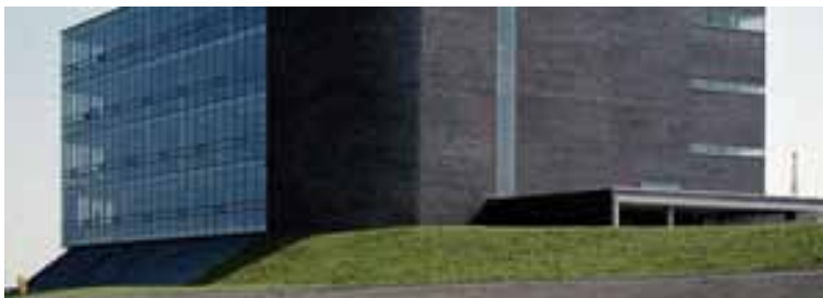
Gebruik van talud tbv beeld en slim ruimtegebruik
