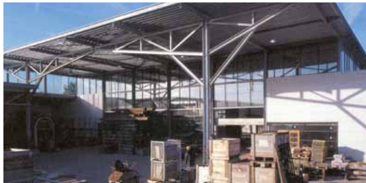
Voorbeeld overdekte opslag
