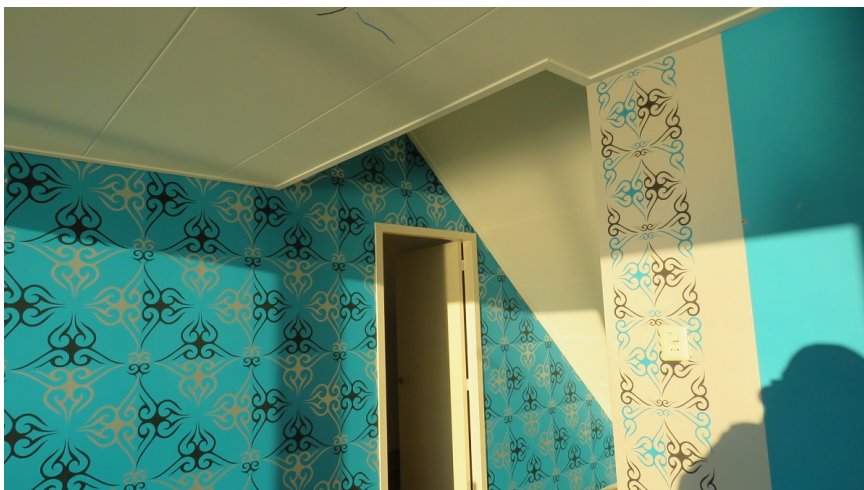
Afbeelding 8: De zolderruimtes zijn open, licht en in gebruik door de bewoners.
