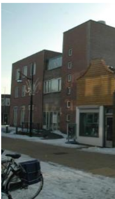
Afbeelding 3: Bestaande situatie bebouwing perceel Kerkbuurt 12
