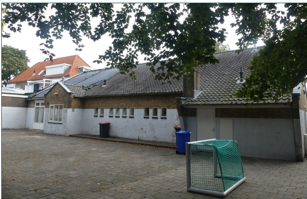
Figuur 2 De bebouwing is opgetrokken uit bakstenen muren en bevat een zadeldak met dakpannen.
