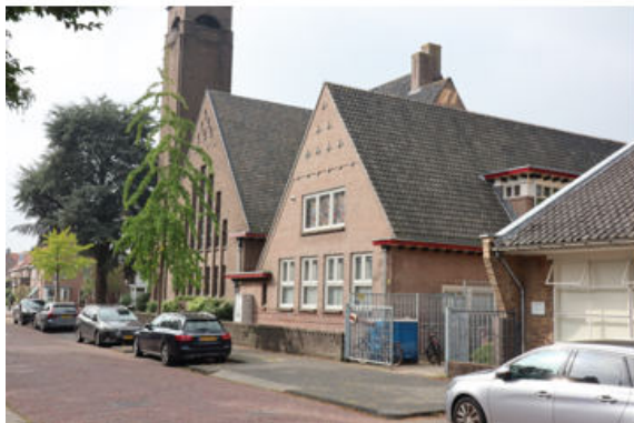
Gereformeerde kerk naast plangebied.
