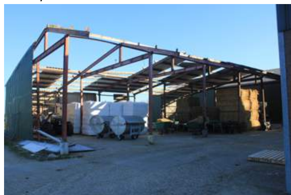
Te slopen veldschuur D.
