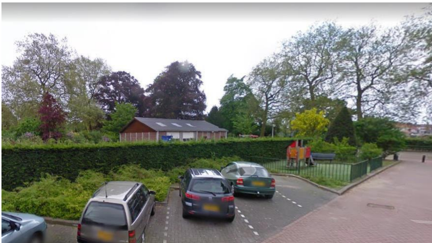
AFBEELDING 8: BEHEERDERSGEBOUW VANUIT NOORDWESTZIJDE
