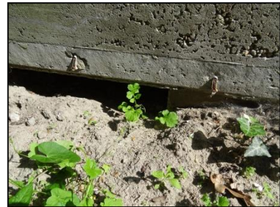
Figuur 11. Toegang tot ruimte onder de fundering.
