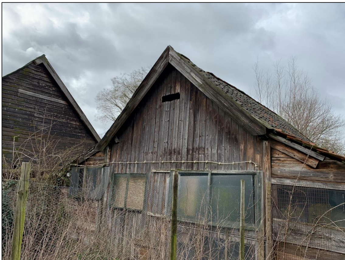
Foto 9: Opening in stal die toegang geeft tot het gebouw
