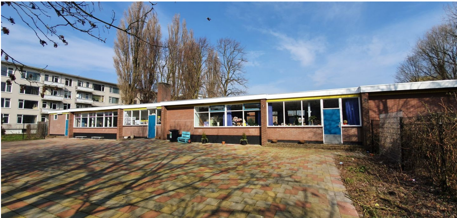
Afbeelding 3: De voorzijde van het binnen het plangebied aanwezige gebouw. Foto. K. de Vries | Ecoresult B.V.
