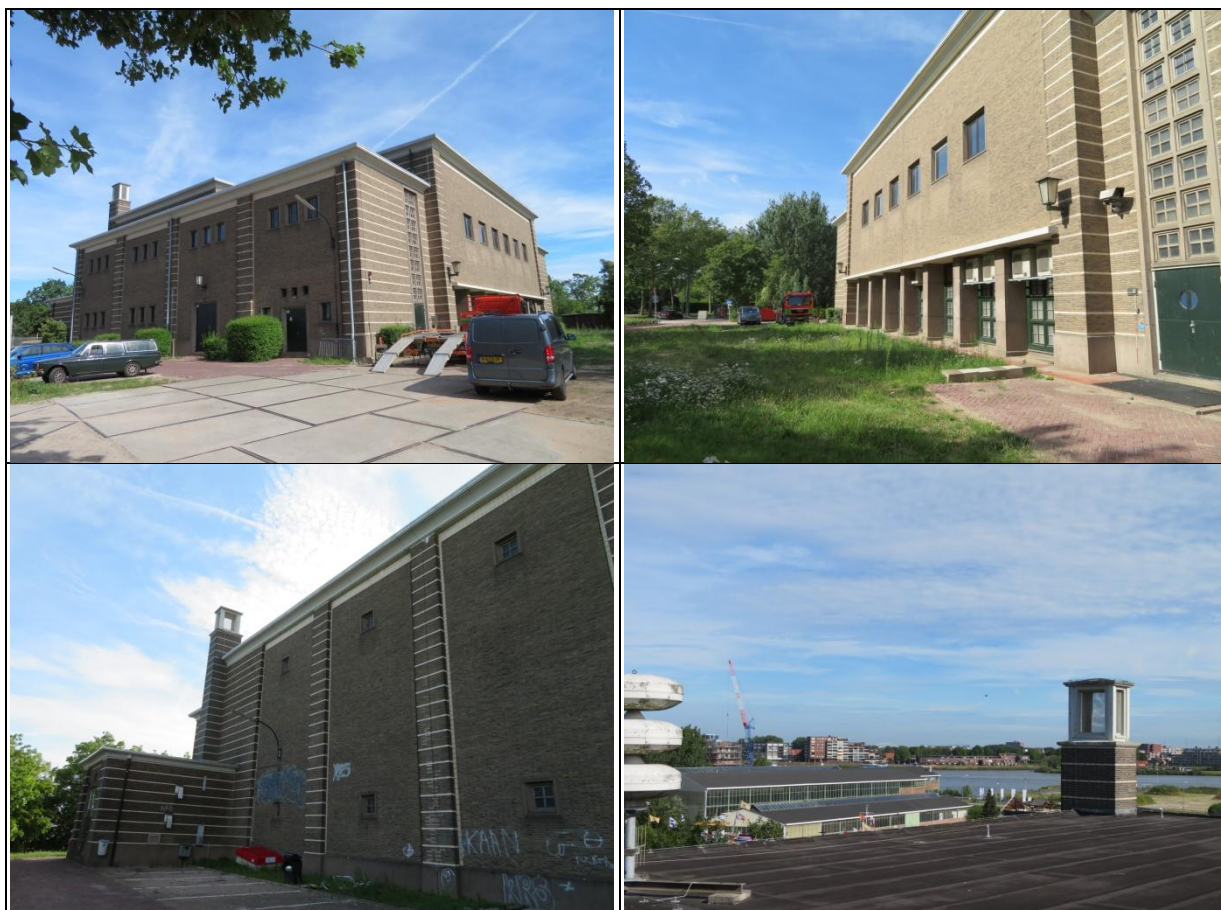
Foto's 1 t/m 4 – Overzichtsfoto's van het plangebied. Boven: het plangebied gezien vanuit het zuiden (links) en vanuit het noordoosten (rechts). Onder: de achtergevel (links) en een deel van het dak aan de achterzijde (rechts).
