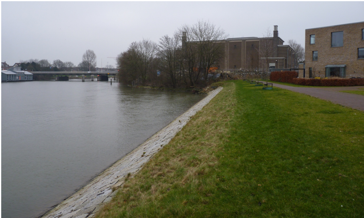
Afbeelding 15: Huidige oeverconstructie bij 50 kV-gebouw (AA-Planadvies).
