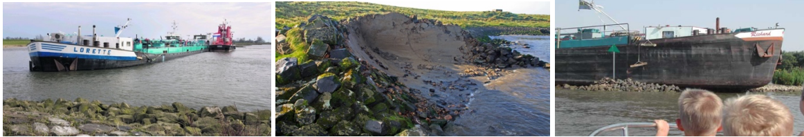
Afbeelding 12: Het verschil in impact bij oeveraanvaring door een geladen of een leeg schip. (Rijkswaterstaat)
