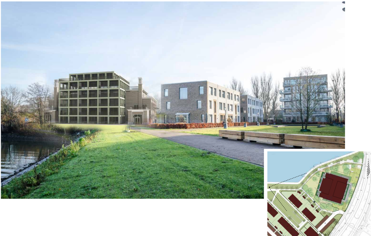
Afbeelding 16: 50 kV-gebouw met geprojecteerde aanbouw.
