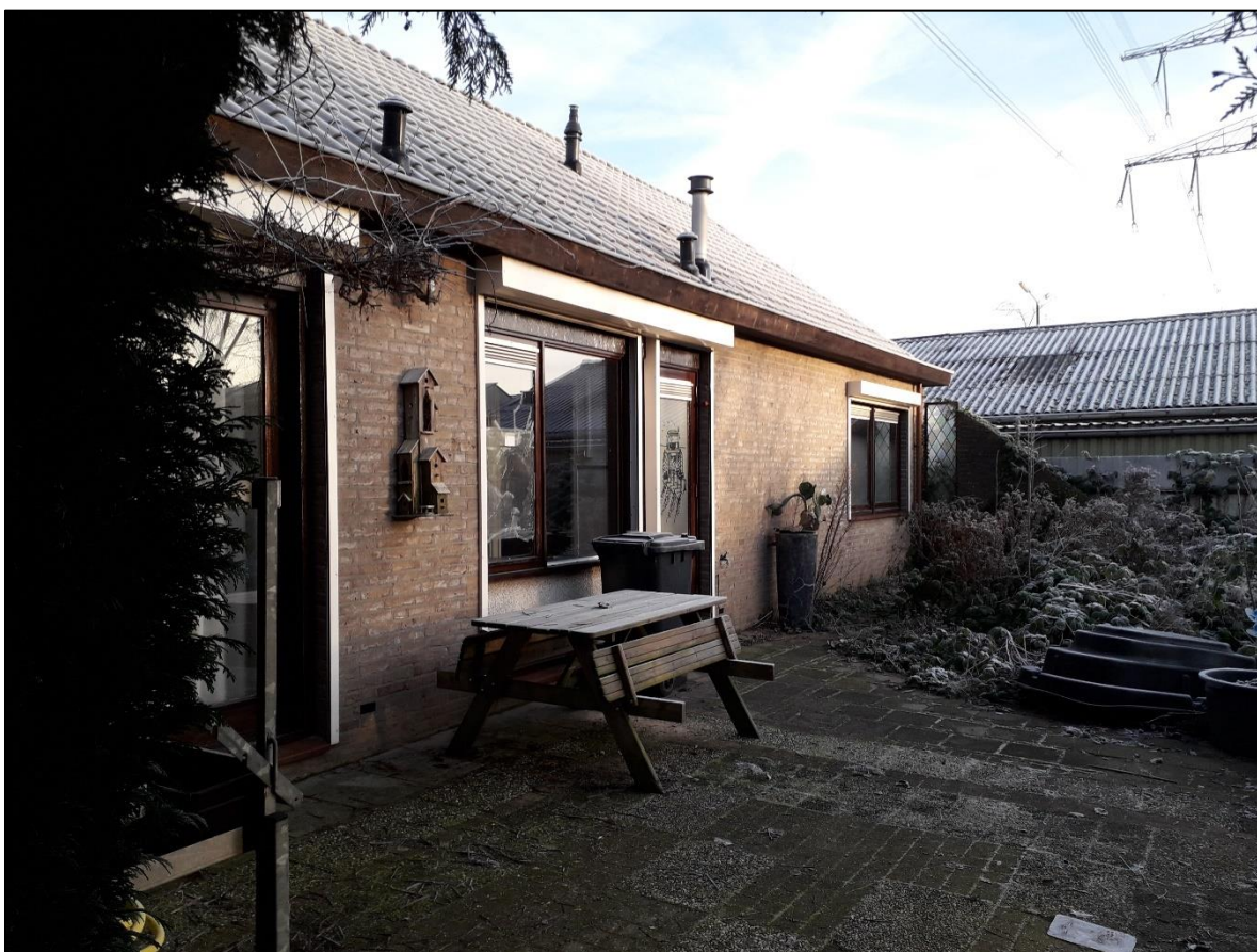
Figuur 19: Achtergevel woning 2.
