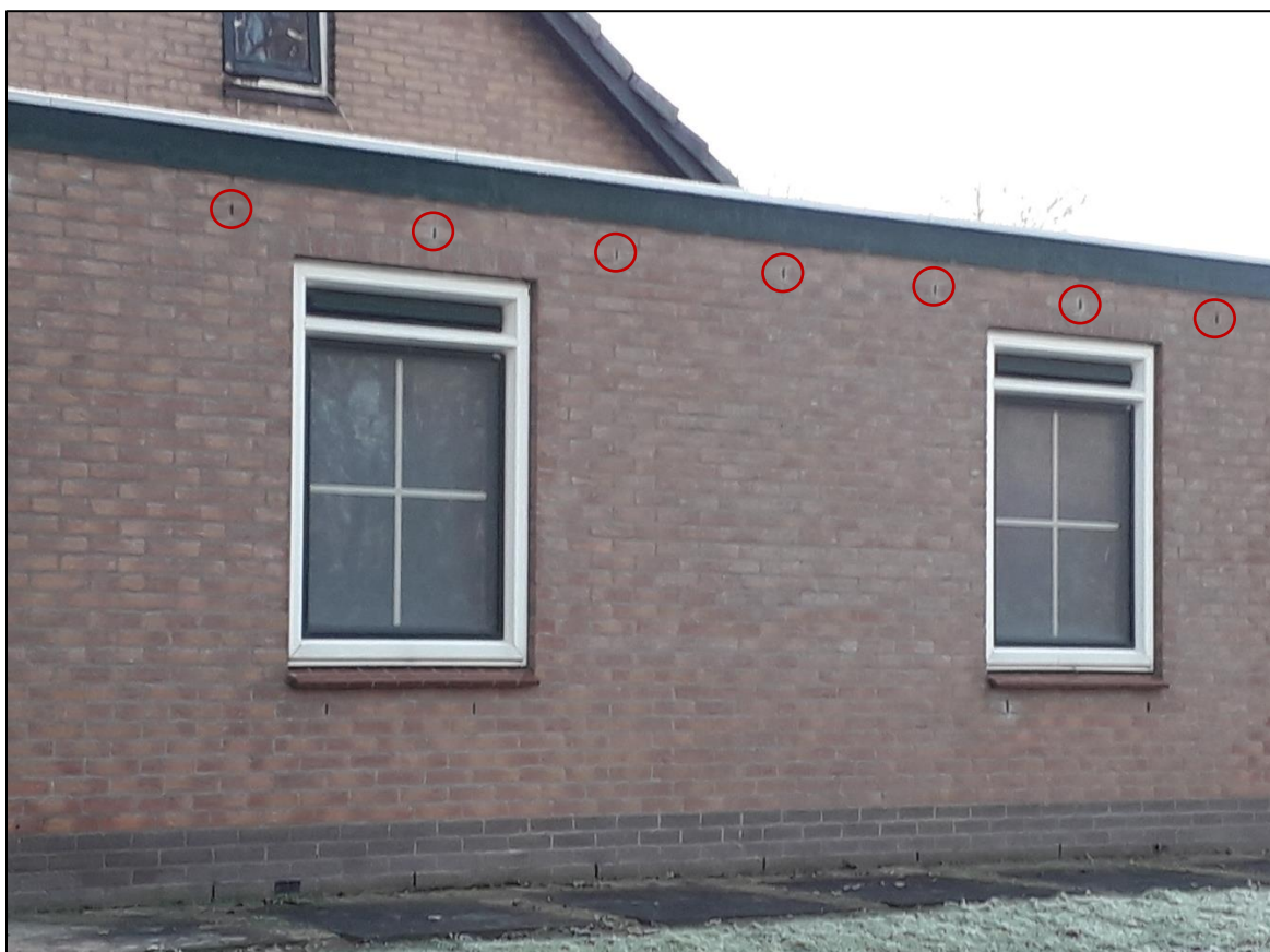
Figuur 3: Spouwgangen in de aanbouw van woning 1 (rood omlijnd).
