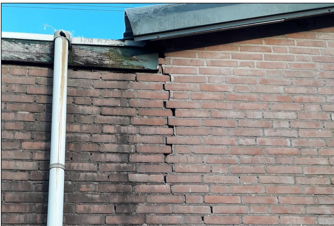
Figuur 5: Paardenstal met scheuren in de gevel aan de zuidkant van het gebouw.
