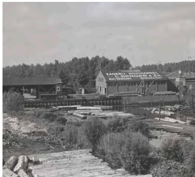
1954 - De houtzagerij aan de Weeskinderdijk aan het balkengat
