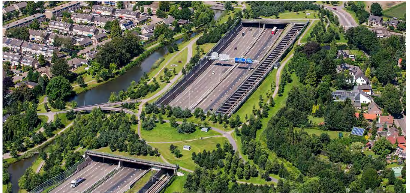
De landschapsbrug draagt bij aan het verlengen van ecologische verbindingen over de A16 heen en zorgt ook voor verbinding tussen buurten.
