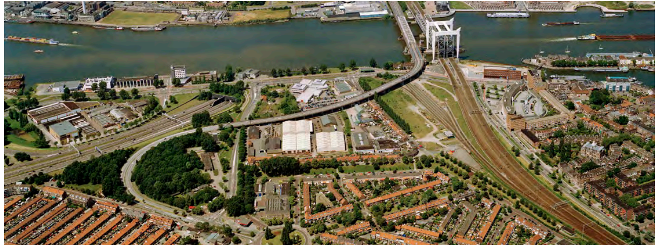
2003 - Luchtfoto Maasterras, impact van infrastructuur nog voor de aanleg van het Weeskinderendijk parkeerterrein
