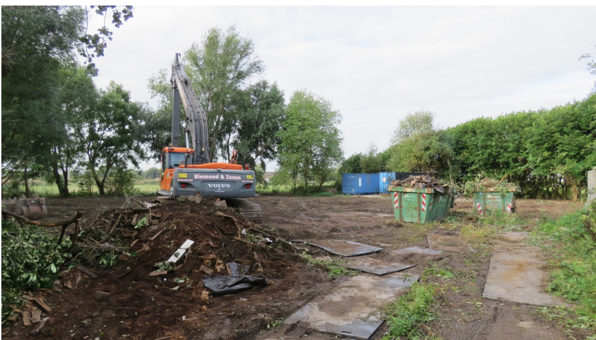
Afbeelding 2: De entree van het terrein, kijkrichting west.
