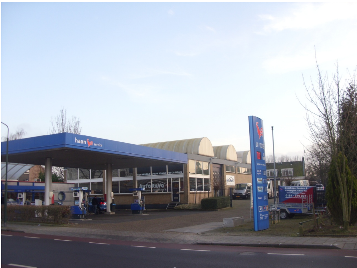
Ligging Tankstation Haan met daarachter Auto Ruvo B.V. (Damstraat 30). Rechts achter het blauwe prijsinformatiebord zijn de ontluichtings- en vulpunten van de ondergrondse tanks te zien. Er zijn een aantal peilbuizen aanwezig.
