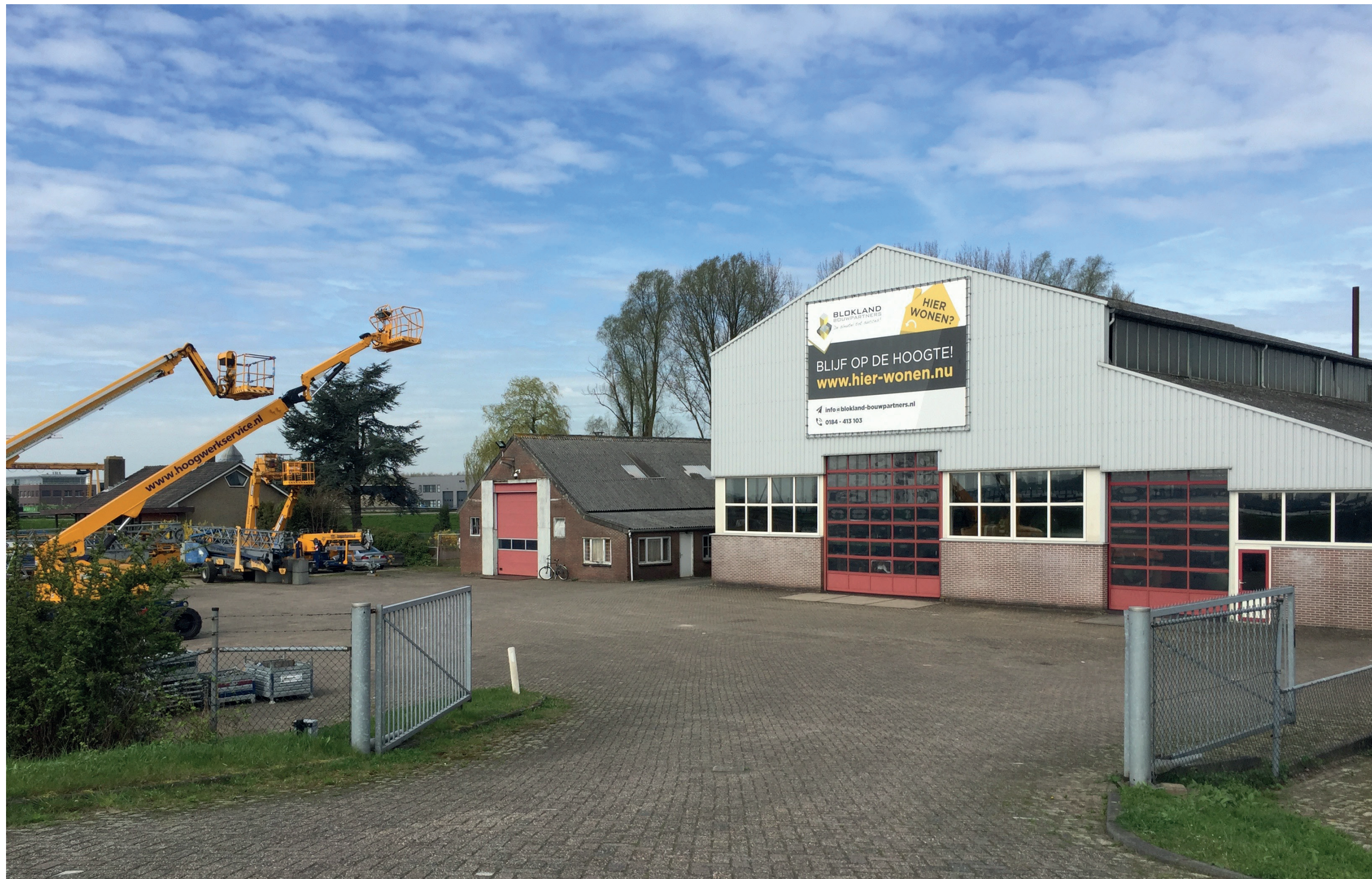
Foto huidige bebouwing
