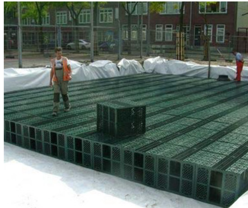
referentie ondergrond krattensysteem waterberging
