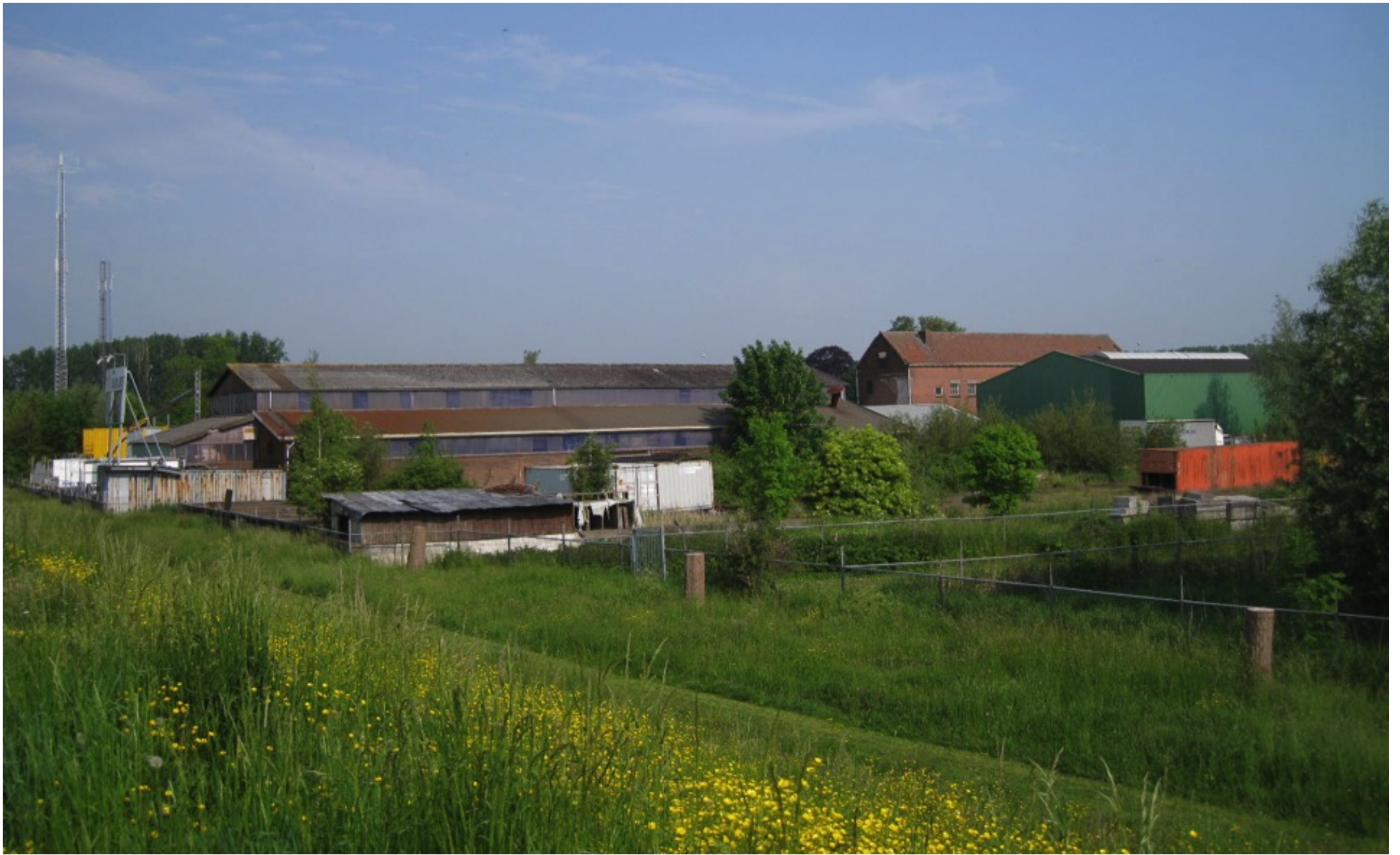
bestaande bebouwing op de locatie IJzergieterij, gezien vanaf het fietspad
