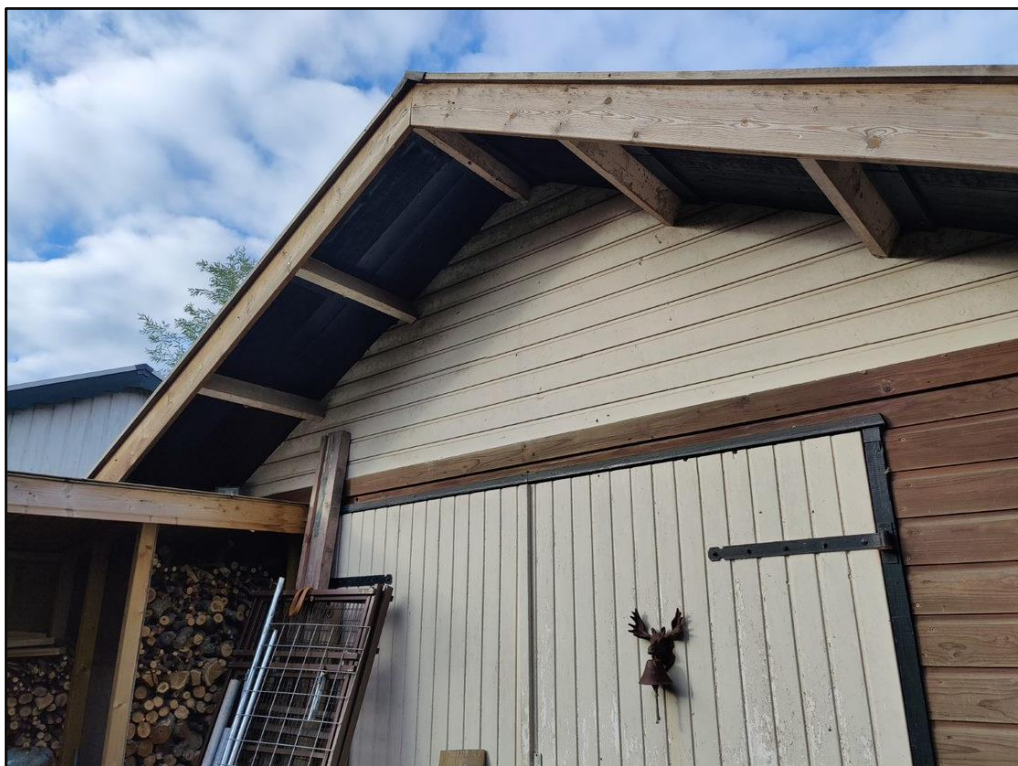
Figuur 1 De te verwijderen schuur is opgetrokken uit houten rabatdelen en beschikt over een bitumen dakbedekking.
