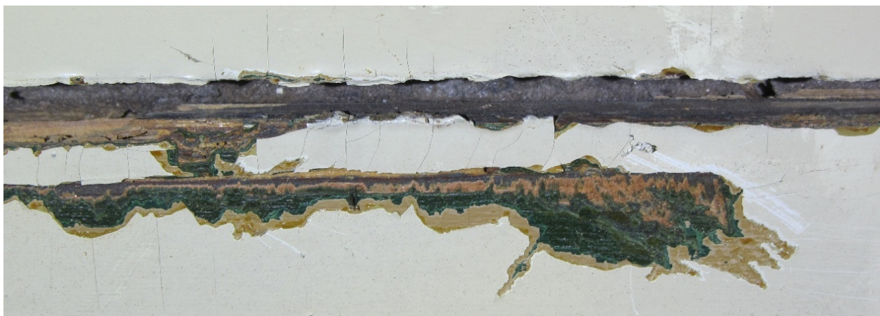
Afb. 24: Kleurmonster 15b waarop een breed scala aan in het verleden toegepaste kleuren op de onderzijde van de houten verdiepingsvloer is te zien op zowel de houten balken als het vloerhout. De foto is genomen van het vloerhout.
