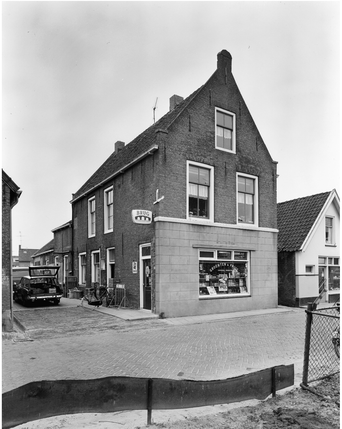
Afb. 29: Foto uit 1969 waarbij de winkelpui die op de vorige afbeelding is te zien nogmaals is vervangen en de gevel deels is gestuct. Ook op deze foto is duidelijk het onderscheid in kleur op raam en kozijn te zien, maar ten opzicht van de vorige afbeelding zijn de kleuren omgedraaid. Nu heeft niet het raam, maar het kozijn de lichtste kleur. Bron: Rijksdienst voor het Cultureel Erfgoed, objectnr. 126.144.
