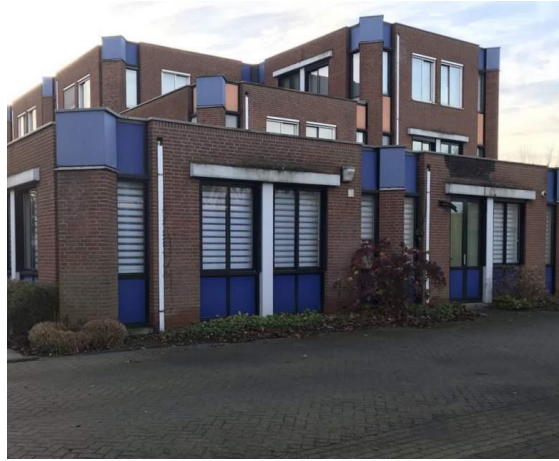
Afbeelding 3. Het kantoorgebouw gezien vanaf de noordwestkant.
