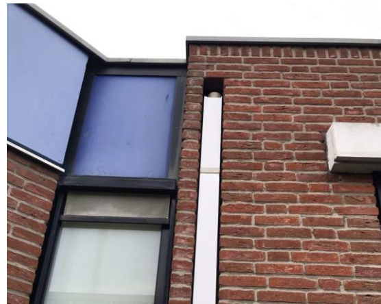
Afbeelding 11. Openingen boven de aanzetting van de regenlijpen, en openingen langs de regeplijnen.
