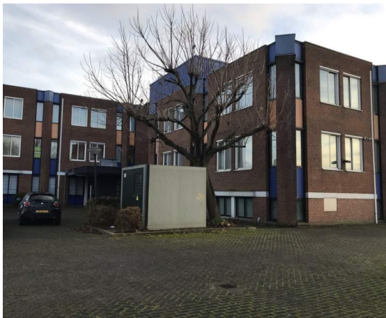
Afbeelding 4. Het kantoorgebouw gezien vanaf de noordkant.
