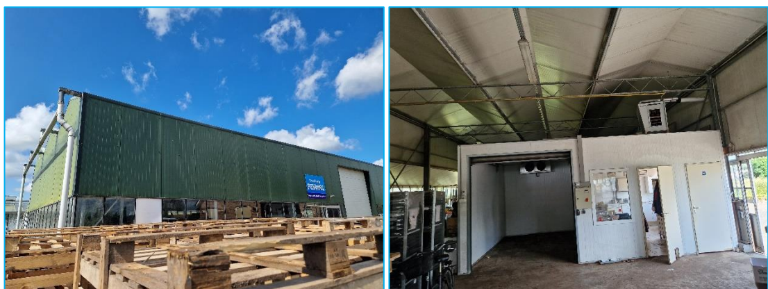
Foto's: Indrukken plangebied. Het te amoveren bedrijfsgebouw.
