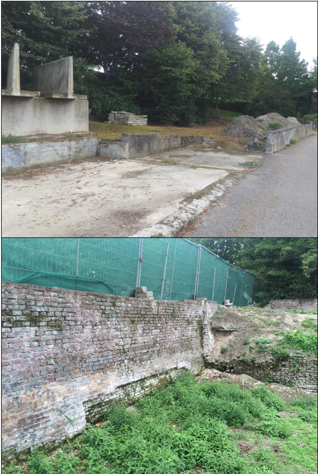
Figuur 12: Opnames in het plangebied (het resterende erf en de funderingen tegen de dijk aan).
