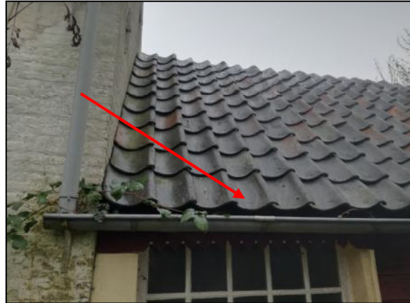
Foto 2: ruimtes onder dakpannen in goot geschikt voor huismus
