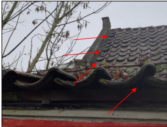
Foto 1: ruimtes onder dakpannen geschikt voor gierzwaluw en huismus
