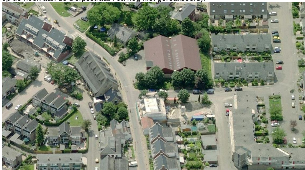
fig. 6 b; luchtfoto recentere situatie t.p.v. de Dorpsstraat / Appelgaard (de nieuwbouw op de hoek aan Dorpsstraat 76a is hier in aanbouw).
