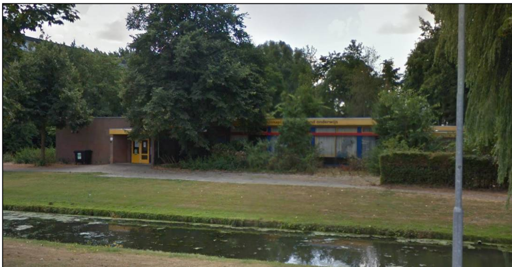
Schoolgebouw voormalige basisschool Lindestein, vlak voor de sloop (bron: Google Streetview)
