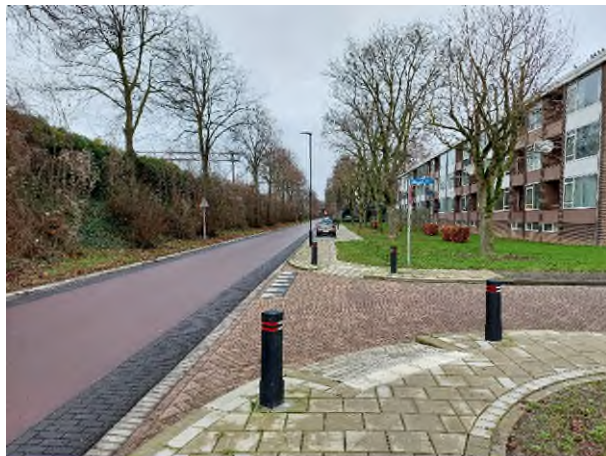
Fotonummer: 2 Omschrijving: Foto asbestverdachte plantsoen Jeroen Boschlaan
