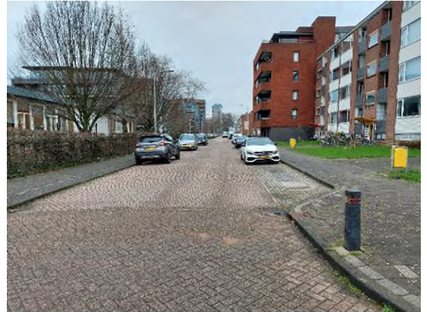
Fotonummer: 8 Omschrijving: Verhardingen kruispunt Uranusstraat - Saturnusstraat
