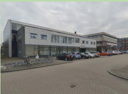
Figuur 2.1 Huidige situatie voorzijde H.A. Lorentzstraat 5.
